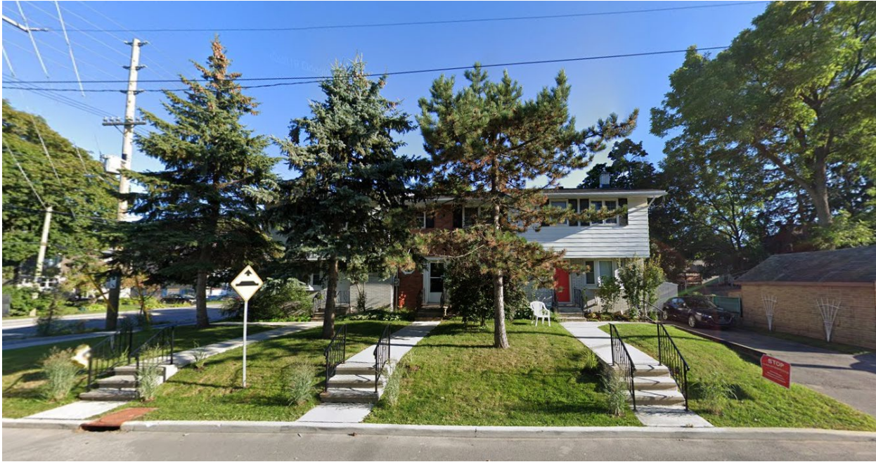
Figure 7 : Lot de trois maisons en rangée situé sur l'avenue Kenwood, non loin de l'avenue Churchill, dans la zone de règlement de restriction provisoire. L'extérieur de ce bâtiment de deux étages a été construit en faisant appel à différents matériaux. Le stationnement est aménagé à l'écart de la façade du bâtiment, pour maximiser la superficie paysagée. Il faut noter que bien que l'on permette généralement la construction de maisons en rangée dans la zone R3, ce n'est pas le cas des zones R3R et R3S, qui constituent la majorité de la zone de règlement de restriction provisoire.
