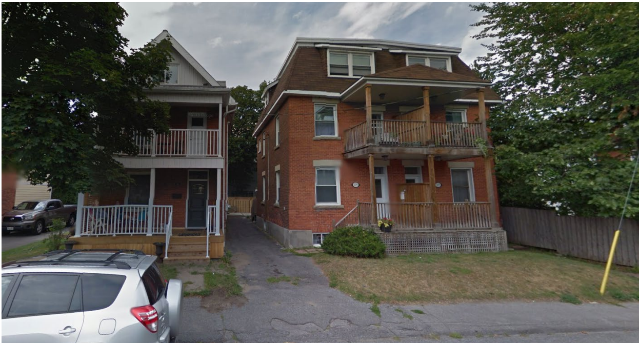
Figure 6 : Le bâtiment de droite comprend six logements et est construit sur l'avenue Wesley, dans la zone de règlement de restriction provisoire, non loin d'une habitation individuelle. Bien qu'il ait trois étages, il est aussi situé non loin de l'avenue Byron, une grande artère de l'aire de l'étude, ce qui permet d'éviter l'aménagement d'un toit plat pour atténuer les incidences potentielles du troisième étage sur la masse. Comme dans l'immeuble précédent, ce type de bâtiment ne serait pas autorisé dans l'actuelle zone R3R.
