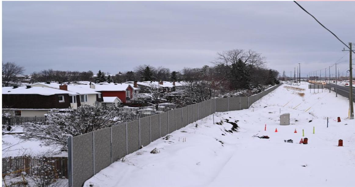
Voici une photo du mur antibruit B03, qui montre un exemple de mur antibruit achevé du côté nord de l'autoroute 174. Nous installons plus de 4,5 km de murs antibruit le long du tronçon est dans le cadre de l'Étape 2 du projet de TLR.
