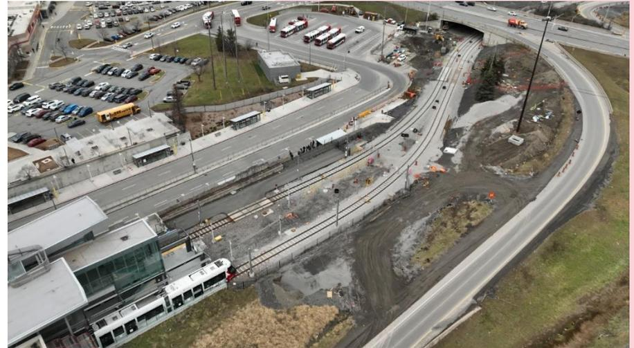
Les équipes de travailleurs, qui ont achevé l'ensemble des travaux de génie civil liés à la construction de la voie de guidage, au terrassement, au drainage, aux fondations du système de suspension caténaire, au sous-ballast et au ballast, ont remis le projet à l'entrepreneur chargé d'installer la voie ferrée.
