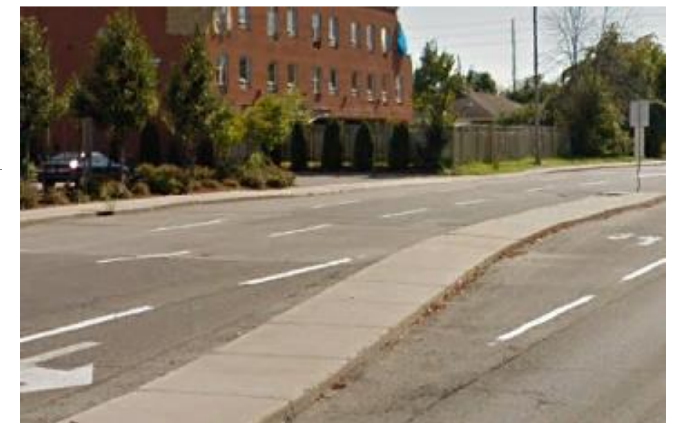
Raised Median with Alternating Left-Turn Lanes / Terre-plein central surélevé avec voies de virage à gauche
