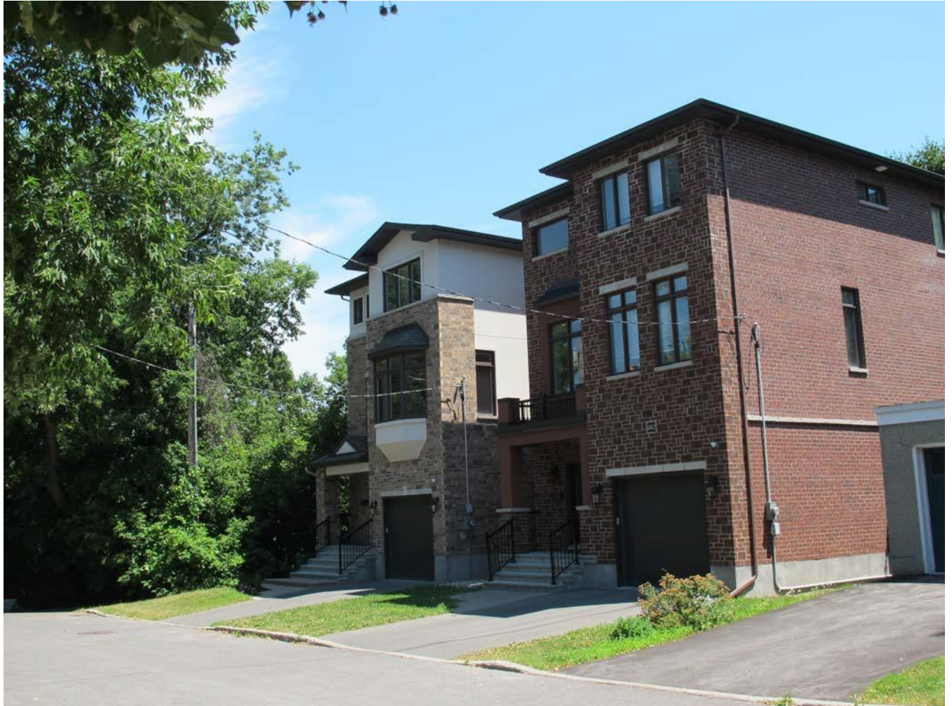
Fig. 14: New infill (Besserer)
