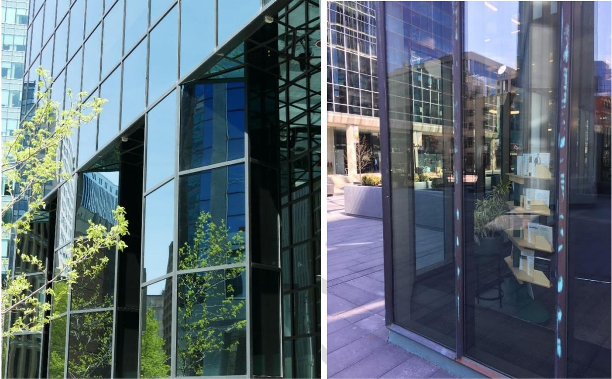
Figure 8 : Pièges potentiels associés à la conception (gauche : labyrinthe de miroirs et effet trou noir; droite : coin en verre).
