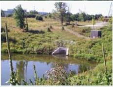
Des mesures liées aux points de rejet: un bassin avec retenue permanente
