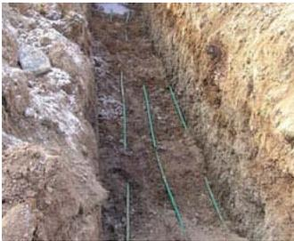
Figure 26 : L'installation d'un système géothermique à boucle souterraine révèle les tuyaux qui serviront au transfert de la chaleur du sol à la maison, ou l'inverse, au moyen d'une pompe située à l'intérieur en vue de chauffer ou de rafraîchir la résidence (installation pour une maison près de Munster).
