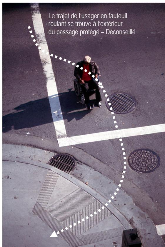
L'alignement de la rampe oblige l'utilisateur en fauteuil roulant à sortir de la zone de passage pour piétons pour accéder au trottoir. Les rampes d'accès doivent être perpendiculaires à la bordure de la chaussée et doivent être alignées avec le passage pour piétons.
