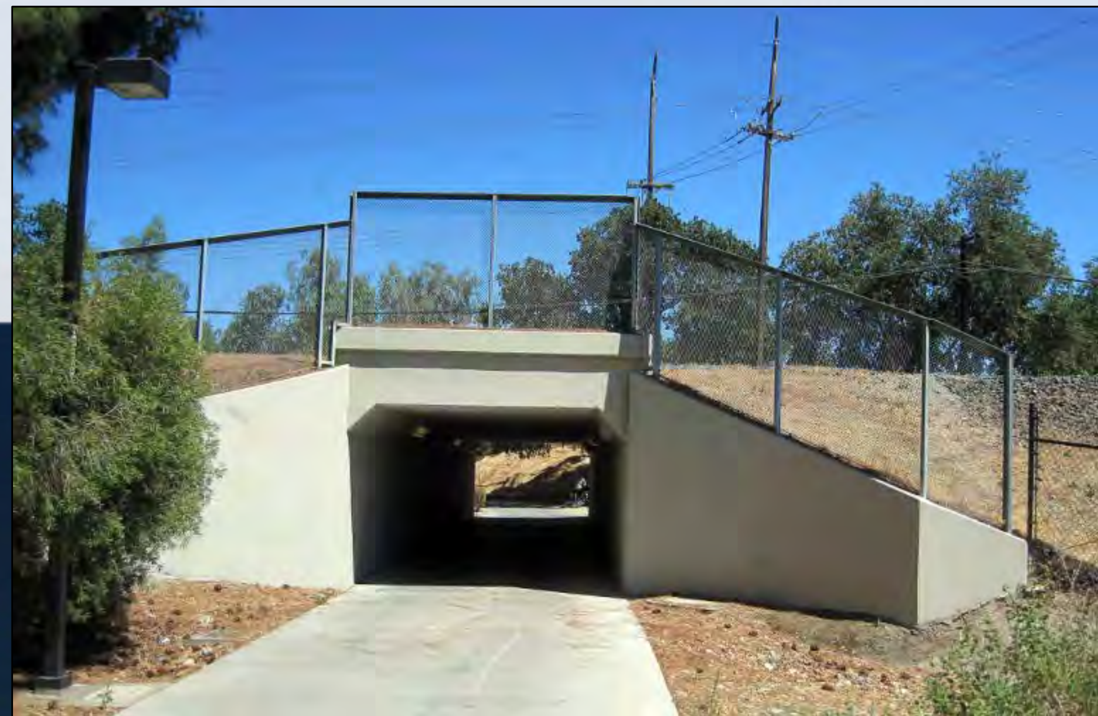
Alternative 1: Box Culvert Option 1 : Ponceau à dalot
