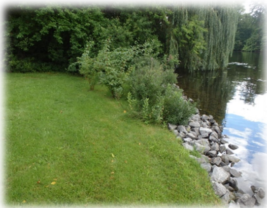
Après : Installation du perré et mise en place de la zone tampon paysagère
