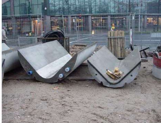
Trockenwetterrinnen Rabtherm Leverkusen (D) Dry weather channels.
